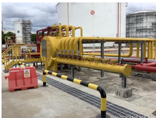
ภาพที่ 5 อุปกรณ์ดับเพลิงภายในคลัง
