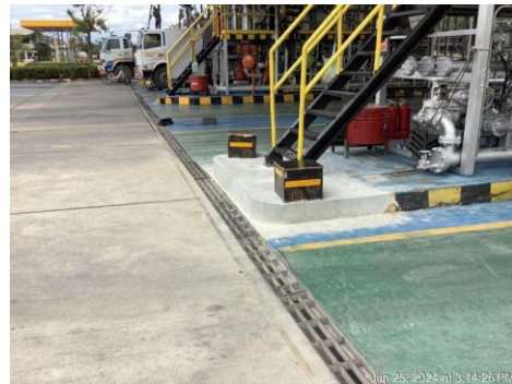
ภาพที่ 2 รางระบายน้ำคอนกรีตภายในคลัง
