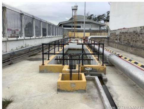
ภาพที่ 9 บ่อดักคราบน้ำมัน Oil interceptor เพื่อทำการแยกน้ำมันออกจากน้ำก่อนระบายสู่ลำรางสาธารณะ
